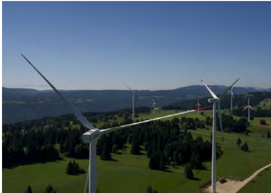
Mt. Crosin, der Windpark mit dem höchsten Stromertrag der Schweiz: 2016: 57 GWh/a, ab 2017 knapp 70 GWh/a erwartet nach Repowering (Foto Juvent SA)
