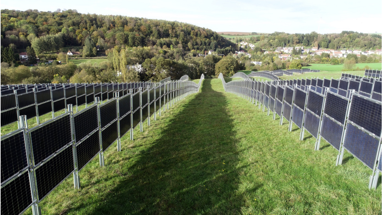
Abb. 1: Das Agri-PV-Konzept der Firma "Next2Sun". Die Reihen werden in Nord-Süd-Richtung angelegt, damit das Potential der bifazialen Anlagen optimal ausgeschöpft werden kann. Die Panels sind erst etwa einen halben Meter über dem Boden angebracht, so dass eine Bewirtschaftung des Landes ohne Beeinträchtigung der Stromproduktion erfolgen kann. Das System ist für die Kombination mit Mähwiesen prädestiniert, denkbar wären aber auch Kombinationen mit anderen Kulturen mit niedrigem Wuchs (Website Next2Sun). Bildmaterial: next2sun.de
