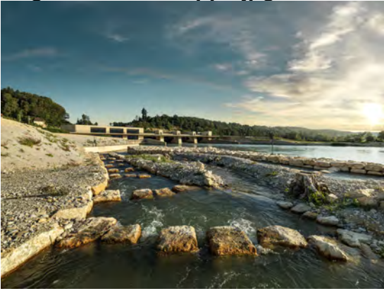
Das neue Kraftwerk Hagneck fügt sich harmonisch in die Landschaft ein (Bild: BKW)
