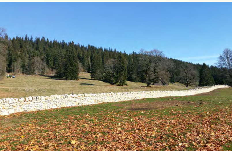
Abbildung 3: Mehrere hundert Metern Trockenmauern konnten entlang des „Chemin des pionniers“ (Gemeinde Val-de-Ruz NE) wieder aufgebaut werden (Foto: © SL-FP)
