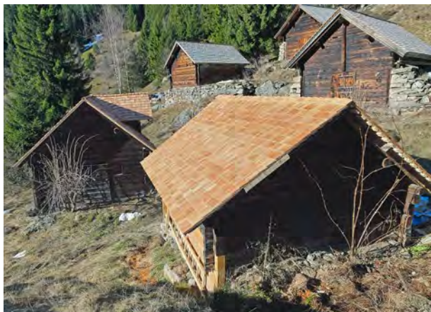
Geissenställe mit neuen Schindeldächern. Chèvreries couvertes de nouveaux toits en tavillons.
