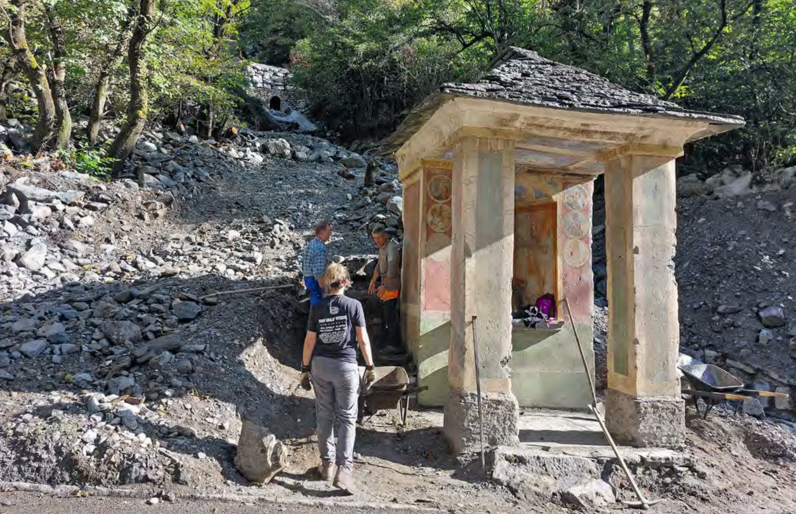
Beginn der Aufräumarbeiten im Sommer 2024. Eine kleine Kapelle blieb verschont. Début des travaux de déblaiement en été 2024. Une petite chapelle est restée intacte.
