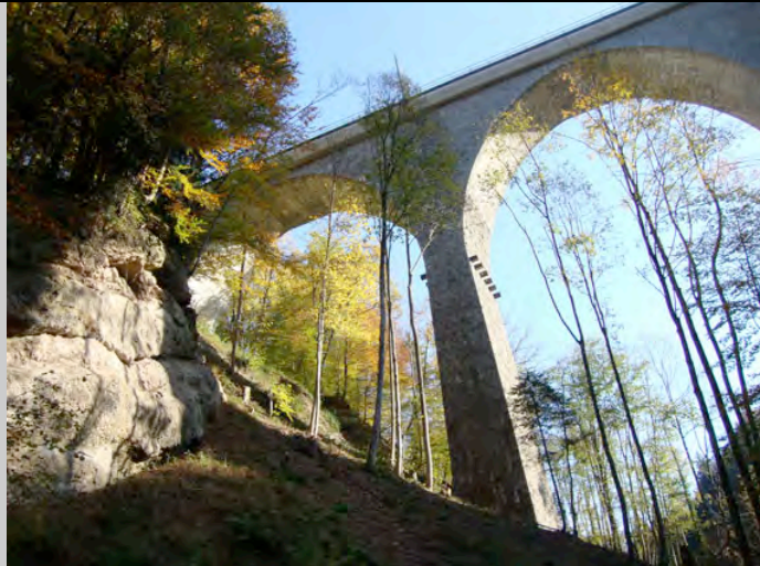
Sitterviadukt bei St. Gallen (Archiv SL)
