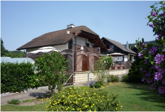
Abbildung 7c: Einfamilienhaussiedlung in Zetzwil
