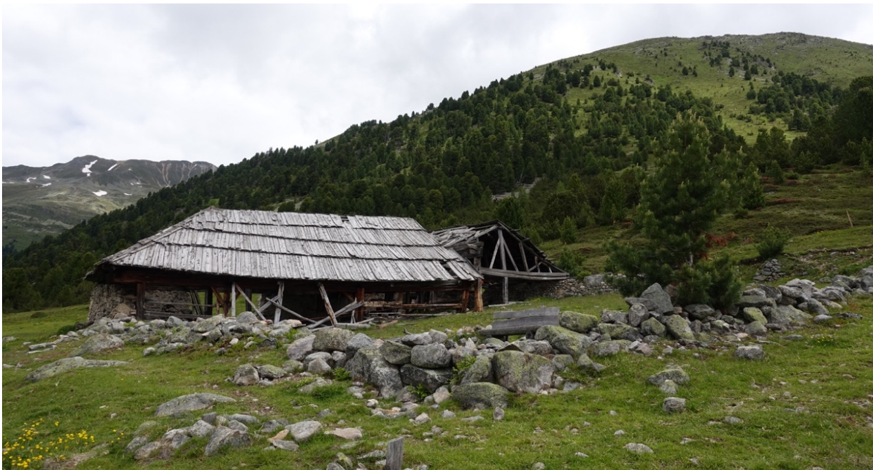
Der eindruckliche Alpstafel Tamangur Dadora (Gemeinde Scuol) aus dem 18. Jahrhundert kann restauriert werden. In Zukunft wird das Gebäude der Alpkorporation Praditschöl als Materialdepot sowie Unterstand für Mensch und Tier dienen. Zudem kann es als Witterungsschutz bei Landschaftspflege-Einsätzen der Biosfera Val Müstair und von Wanderern und Tourengängern genutzt werden. (Foto: SL-FP)
