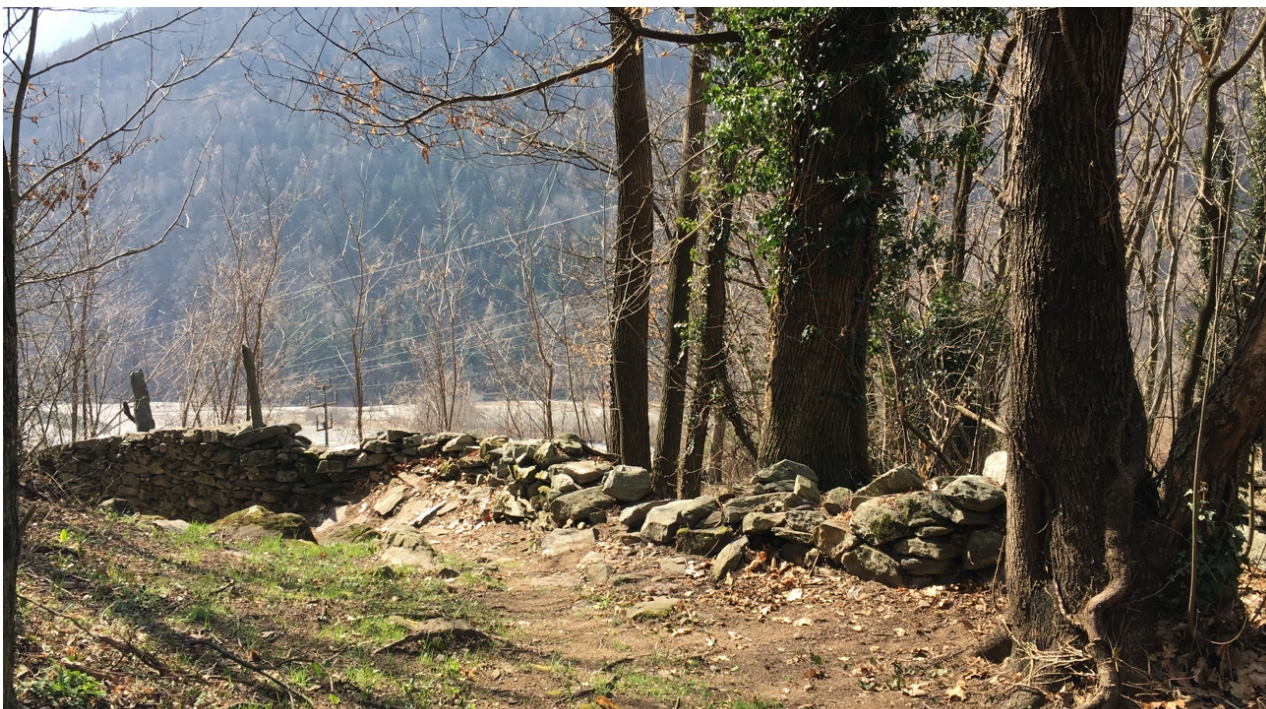
In und um das Dorf Giumaglio im Maggiatal verläuft ein Netzwerk von historischen Wegen. Die Trockensteinmauern, die diese Wege säumen, können nun instand gestellt werden. So wird nicht nur ein Kulturgut erhalten sondern es können auch attraktive Wandermöglichkeiten für Einheimische und Gäste der Region geschaffen werden. (Foto: zur Verfügung gestellt)
