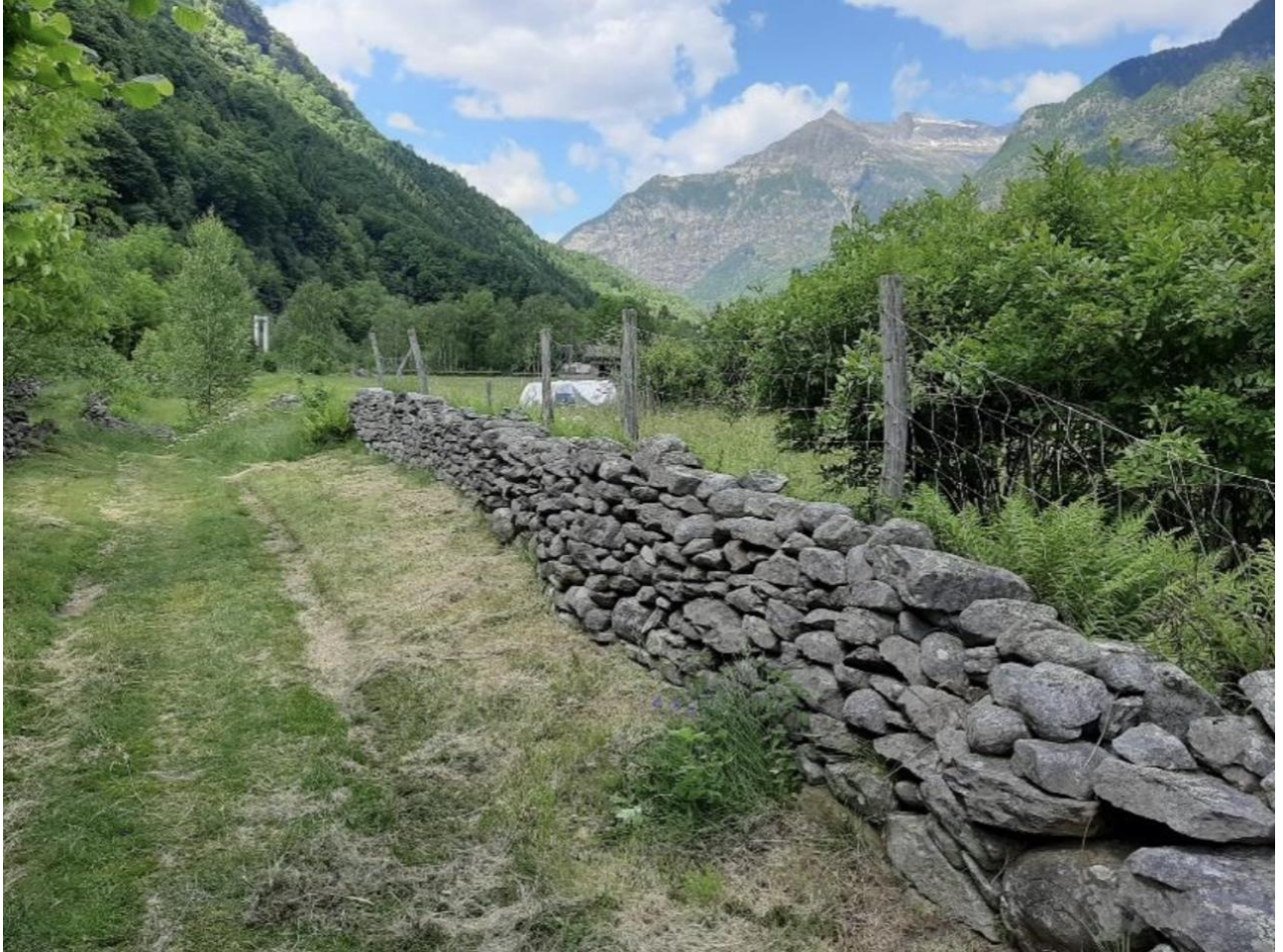
Foto 3: Trockenmauer in der Region Alnasca in der Nähe von Brione Verzasca (Foto: © Francesco Hess)
