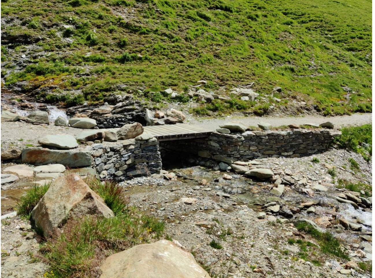
Foto 4: Die historischen Kunstbauten am Tomülpäss werden sorgfältig erneuert (Foto: © SL-FP)
