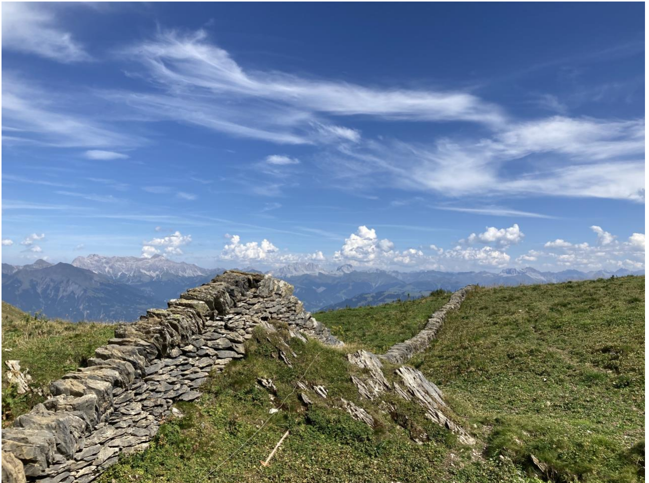
Foto 2: Eine Trockenmauer so weit das Auge reicht: Am Calanda erstreckt sich eine imposante Trockenmauer auf einer Länge von über 2 km und überwindet mehr als 600 Höhenmeter. (Foto: oekoskop)
