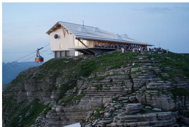
Bild 01) Gipfelgebäude Chäserrugg (© Toggenburg Bergbahnen AG)
