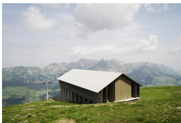
Bild 03) Bergstation Gondelbahn Espel- Stöfeli-Chäserrugg (© Toggenburg Bergbahnen AG)
