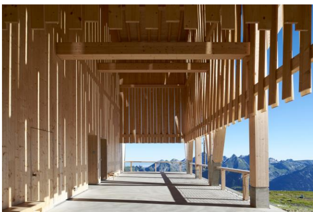
Bild 02) Gipfelgebäude Chäserrugg (© Toggenburg Bergbahnen AG)
