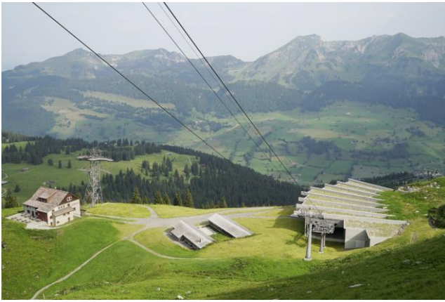
Bild 04) Mittelstation Gondelbahn Espel-Stöfeli-Chäserrugg (© Toggenburg Bergbahnen AG)
