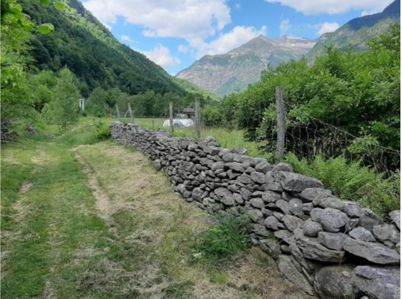
Photo 3: Mur de pierres sèches dans la région d'Alasca, près de Brione Verzasca (photo: © Francesco Hess)
