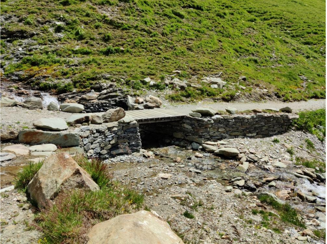
Photo 4: Les ouvrages d'art historiques du col du Tomül sont rénovés avec soin (photo: © SL-FP)
