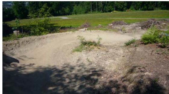
Ill. 10 Élargissement de la bande de roulement sur la piste VTT du Gurten. Source : © D. Müller 2015
