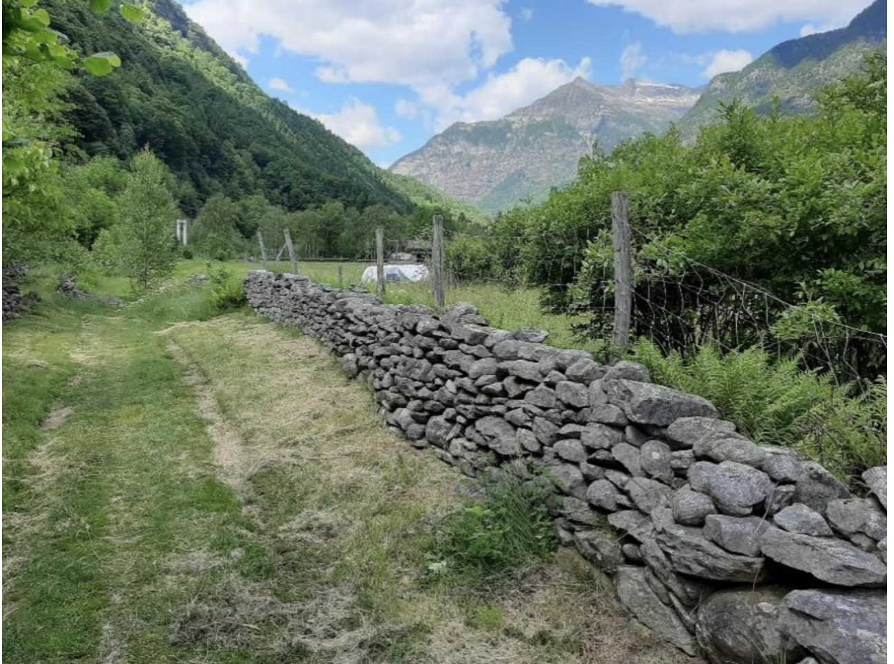
Foto 3: Muro a secco nella regione di Alnasca vicino a Brione Verzasca. (Foto: © Francesco Hess)
