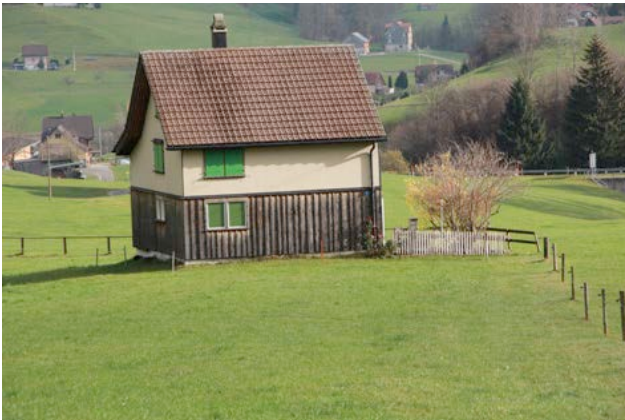
9) Untere Bitzi, Gonten AI 2014 Foto: Bau- und Umweltdepartement
